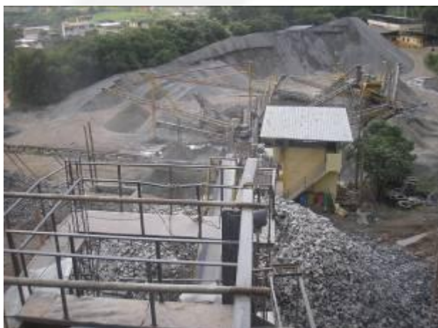
Foto 03: Britador e pátio de estocagem
