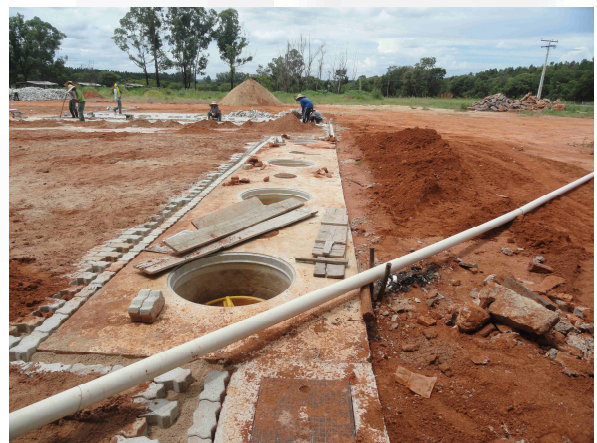
Imagem 02: Instalação dos tanques
