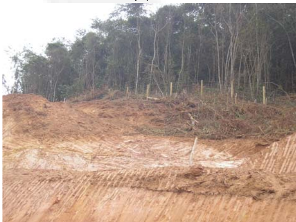
Foto 5: Talude com resíduo lenhoso.
