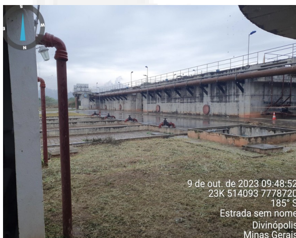
Foto 03. Área para secagem do Lodo.
