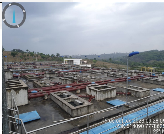
Foto 02. Reator Anaeróbico de Fluxo Ascendente (UASB).
