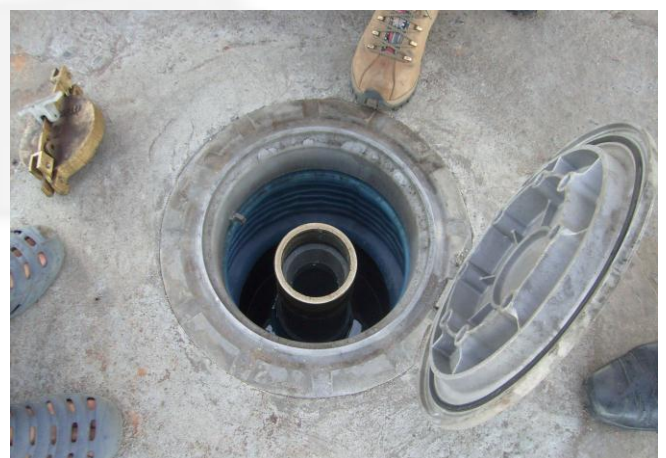
Foto 10. SUMP Ponto de Descarga
