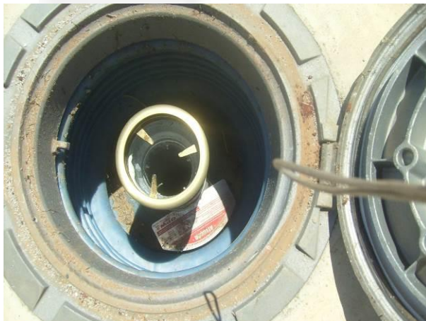
Foto 07. Boca de descarga selada
