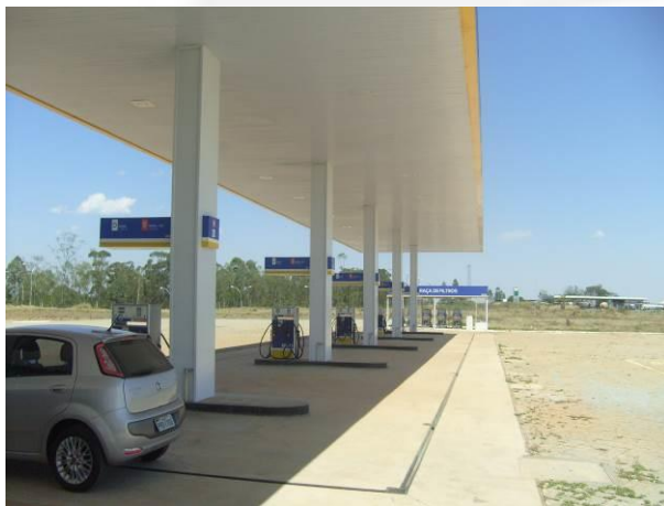
Foto 01. Área de abastecimento e pátio de manobras
