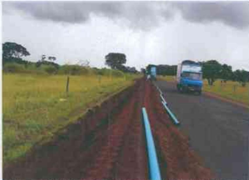
Figura 4 – Vista no sentido Norte da Tubulação da adutora do Posto Tabocão III para interligação à rede de coleta de esgoto municipal em fase de instalação.
