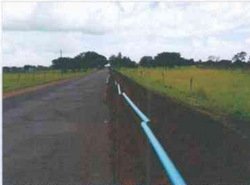
**Figura 5 – Vista no sentido Sul da Tubulação da adutora do Posto Tabocão III para interligação à rede de coleta de esgoto municipal em fase de instalação.**
