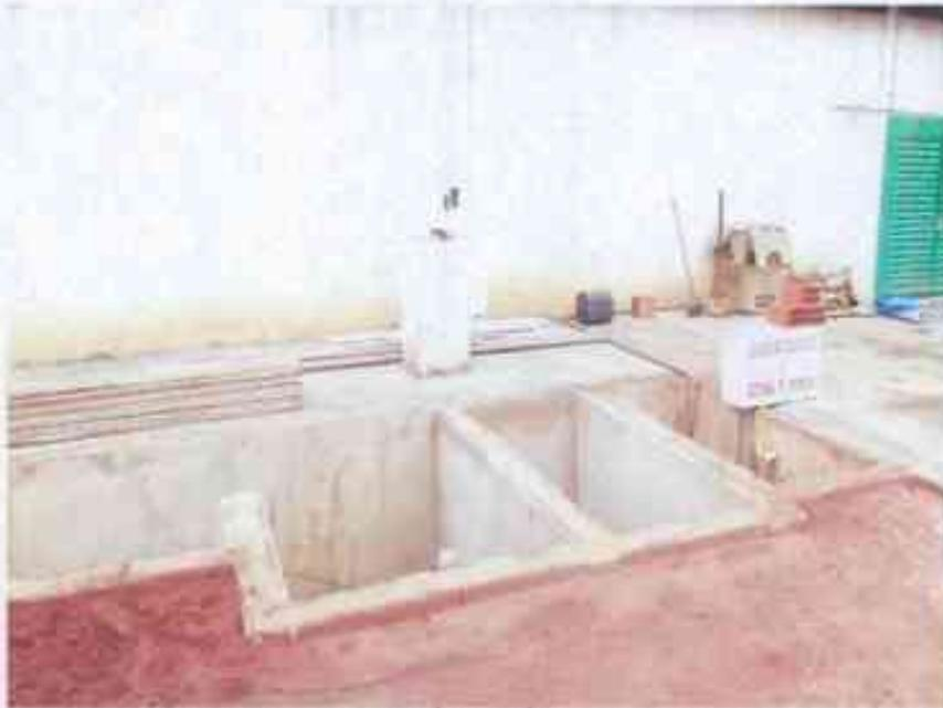
Figura 3 – Vista das Caixas Separadoras de Água e Óleo da ETE do Posto Tabocão III em fase de construção no segundo semestre de 2013.
