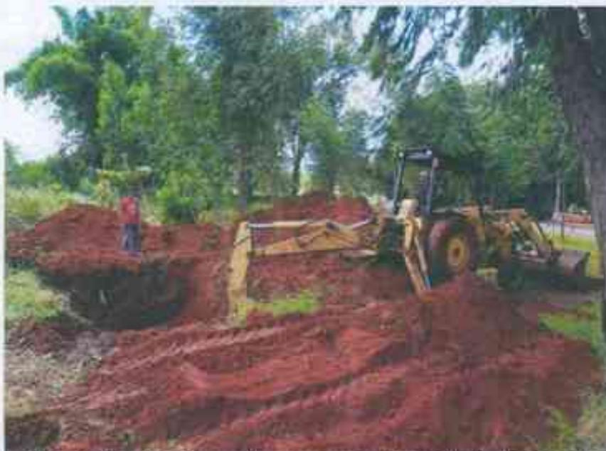
**Figura 6 – Vista dos trabalhos de terraplanagem para instalação da tubulação de interligação à rede de coleta de esgoto municipal em fase de instalação.**
