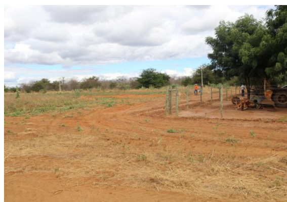
Foto 06. Local de instalação dos reservatórios de (vinhaça/água residuárias).
