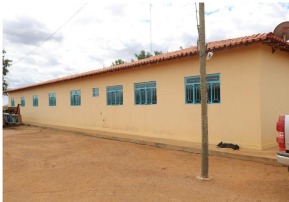
Foto 01. Estruturas já existentes
