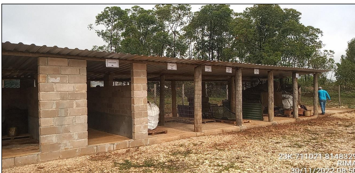
Figura 11: Central de armazenamento de resíduos sólidos.
