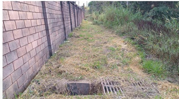
Dispositivo de drenagem da BR-356 no terreno do Lagoa da Serra
