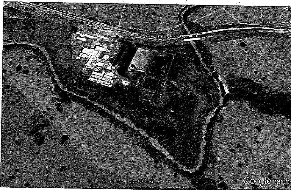
Figura 1- Vista aérea do empreendimento. Fonte: Google Earth
