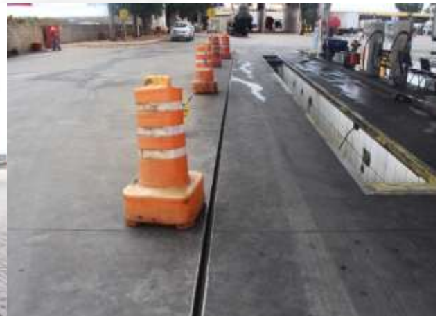
Foto 4: Fosso para troca de óleo.
