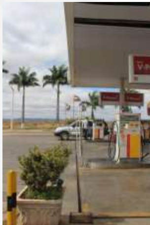
Foto 1: Pista de abastecimento de gasolina e álcool com canaletas e cobertura.
