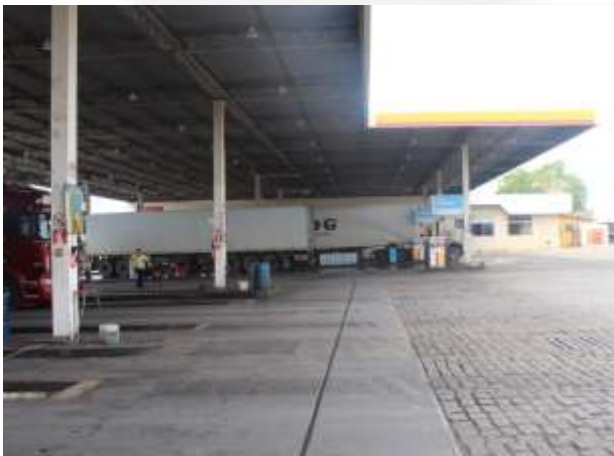
Foto 3: Pista de abastecimento de diesel.
