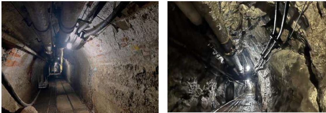
Figura 23: Trecho revestido da galeria principal (a esquerda) e com aspecto de rocha natural (a direita).
