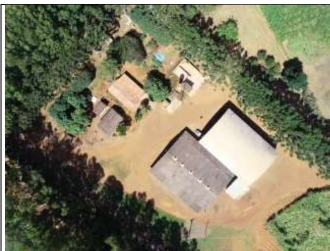
Foto 01. Estruturas de apoio.
