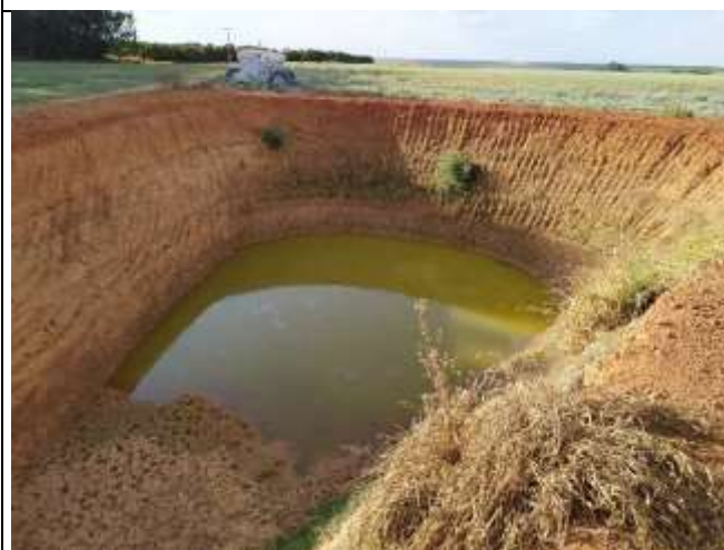
Foto 03. Barragem de acumulação de água dos sistemas de drenagem pluvial das áreas de plantio.
