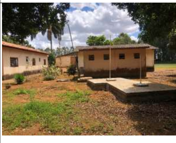
Foto 04. Sistema de fossa séptica biodigestora de uma residência.
