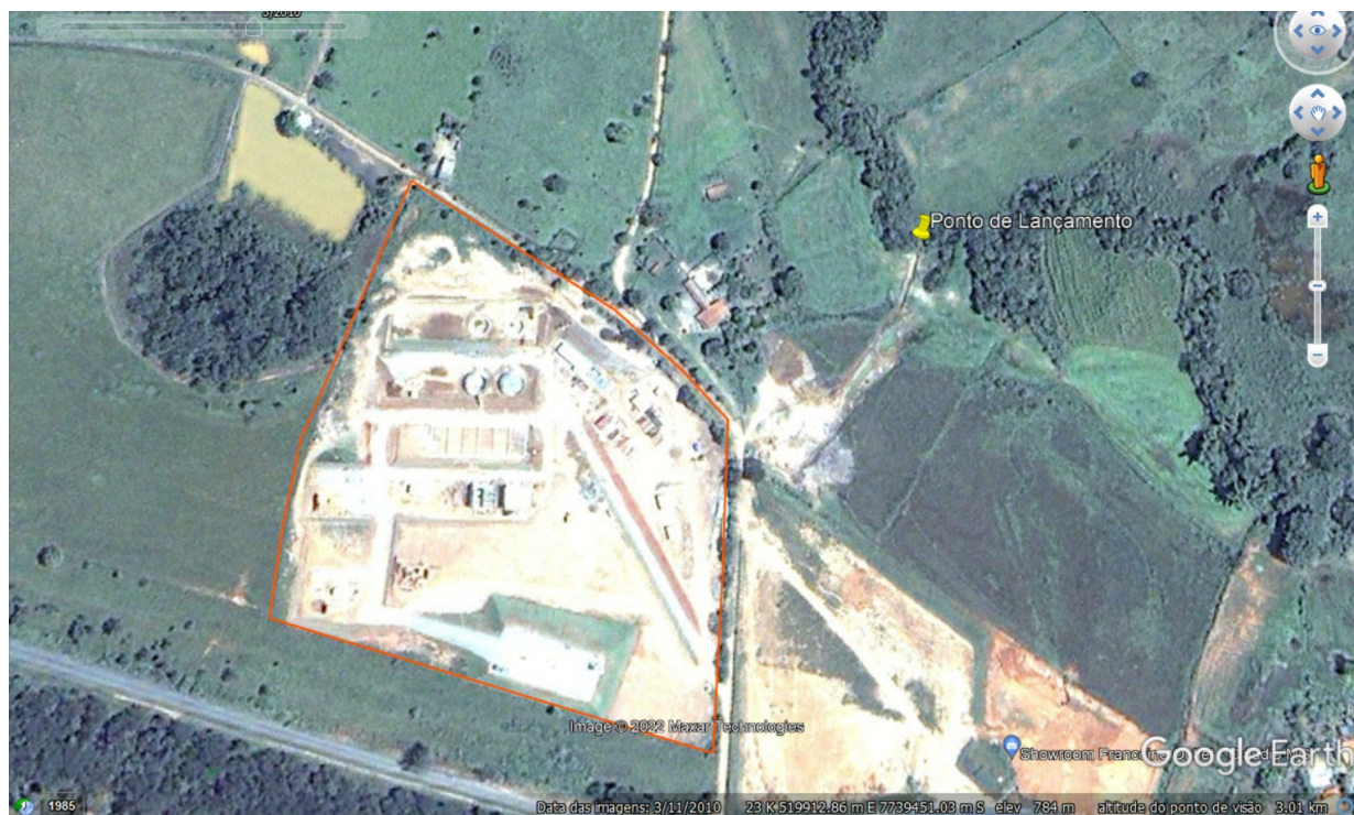
Figura 01: Imagem referente ao ano de 2010 em que se verifica as obras de implantação do empreendimento (Polígono vermelho) e ponto de lançamento dos efluentes líquidos no Ribeirão do Cláudio.
