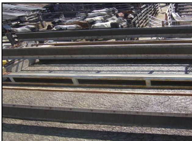
Foto 03. Flotador para o tratamento de efluentes do Matadouro S. Geraldo.
