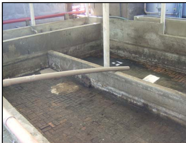
Foto 04. Leito de secagem de resíduos do Matadouro S. Geraldo.
