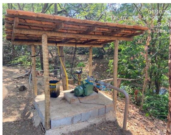
FOTO 08. Sistema motobomba para captação de água superficial.
