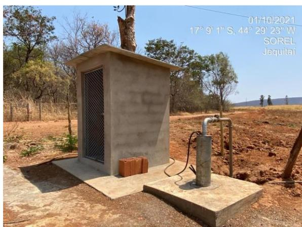
FOTO 07. Poço profundo para captação de água subterrânea.
