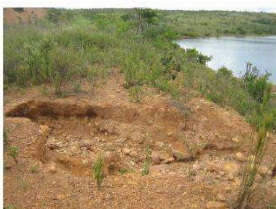
Imagem 07: Processo erosivo no talude de jusante. Fonte: Laudo de barragens, p. 10.
