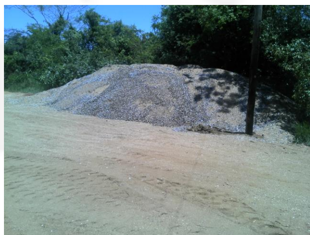
Resíduo de Areia (cascalho e conchas) utilizados na pavimentação de vias internas.
