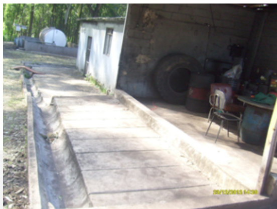
Foto 04. Canaletas ao redor da área da oficina
