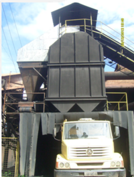
Foto 05. Silos de moinha
