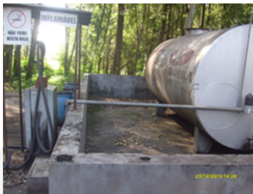
Foto 08. Área de abastecimento.
