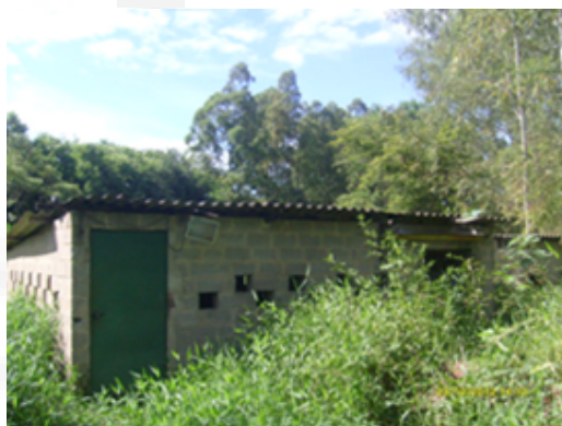
Foto 10. Casa de bombas.
