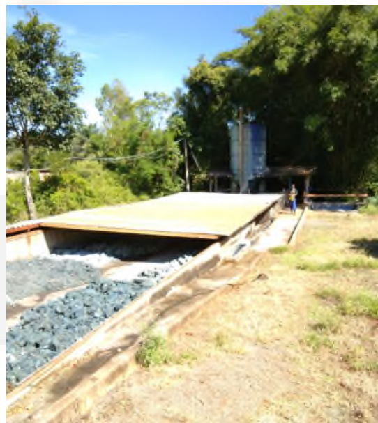
Foto 04. Estação Tratamento Esgoto Industrial
