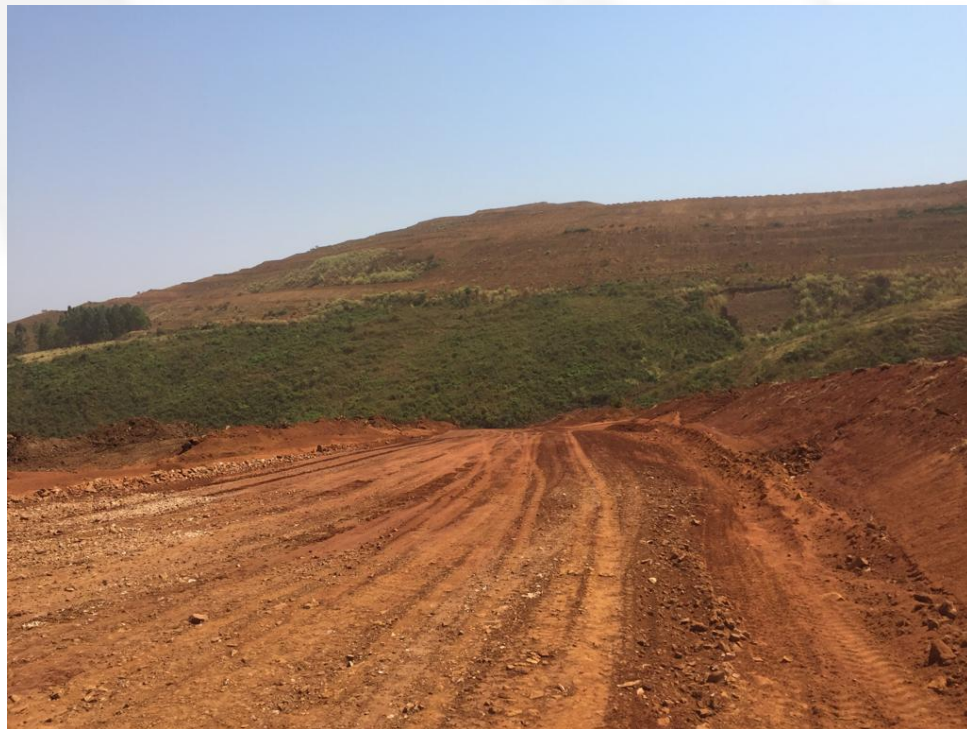
Imagem 02: Estrada de acesso e, ao fundo, o vale onde será realizada a disposição do estéril.
