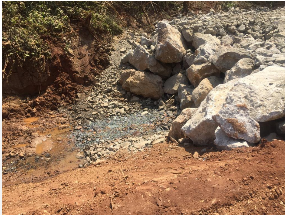
Imagem 01: Dreno de fundo.
