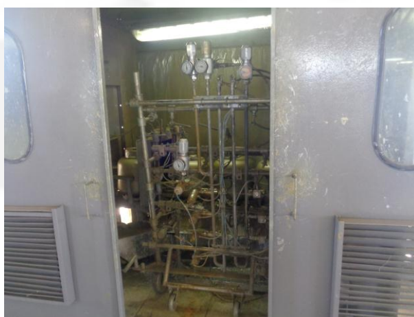
Foto 04. Cabine de pintura de botijões residenciais.
