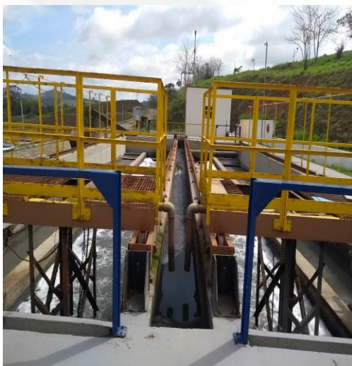
Foto 03. Desarenador aerado.
