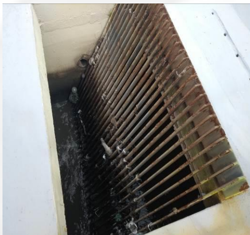
Foto 03. Desarenador aerado.
