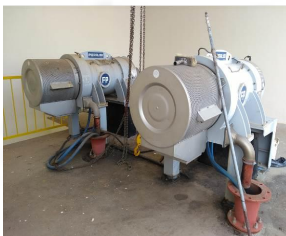
Foto 08. Centrífuga de lodo
