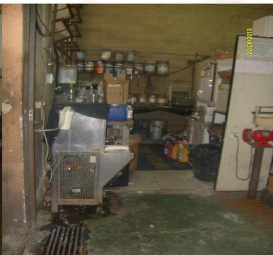
**Foto 04.** Local de armazenamento de produtos químicos. Destaque para o direcionamento do efluente para canaletas interligadas à ETEI.
