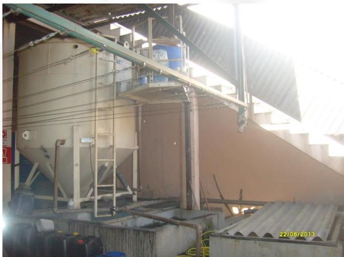
**Foto 08.** Estação de Tratamento de Efluentes Industriais.
