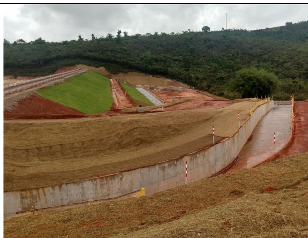
Figura 4: Fluxo residual a jusante Dique 4
