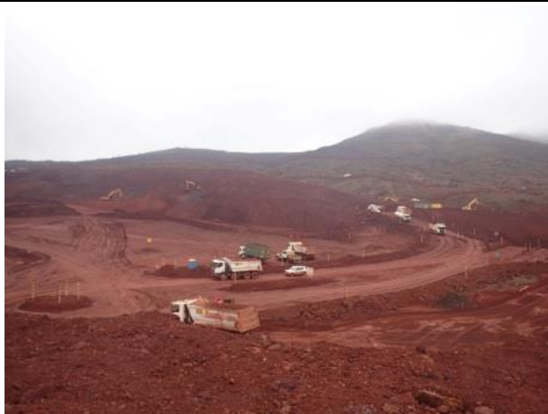
Figura 1: Obras para abertura de cava
