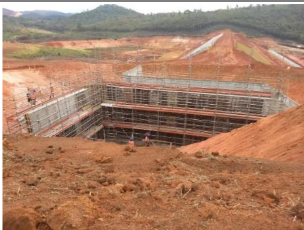
Figura 3: Obras do Dique 4
