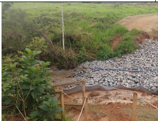
Figura 3: Fluxo residual a jusante Dique 3
