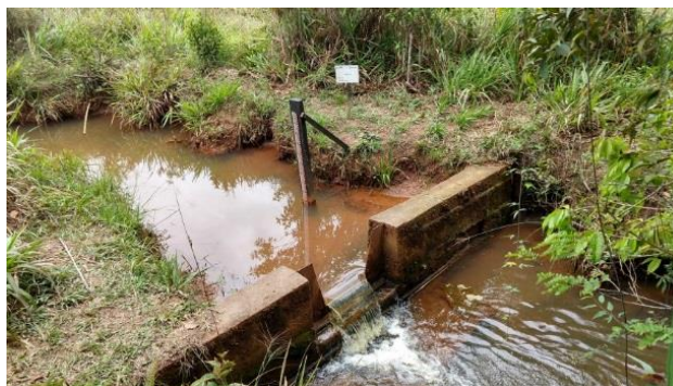
Figura 4: Régua e vertedouro para controle de vazão.
