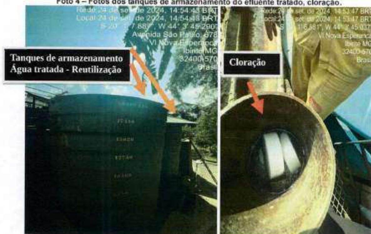
Foto 4 – Fotos dos tanques de armazenamento do efluente tratado, cloração.
