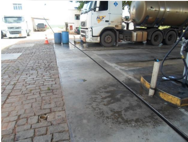
FOTO 07- Canaletas de drenagem de efluentes.
