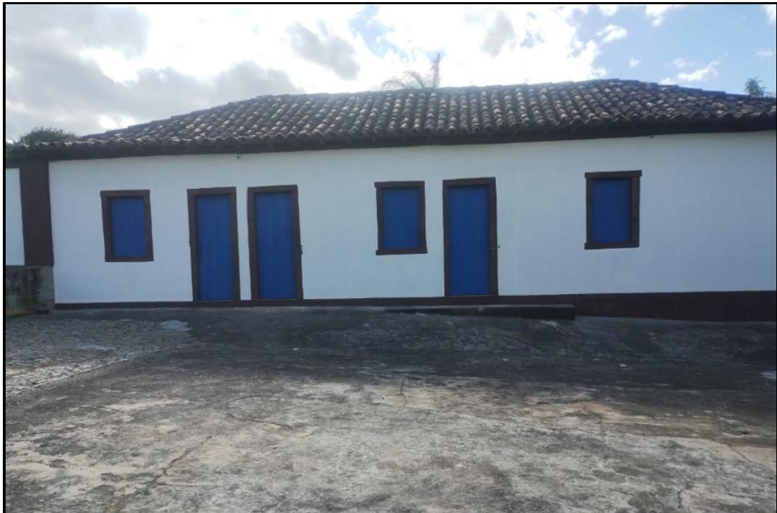
Sede da Antiga Fazenda do Confisco localizada na Avenida Geraldo Rocha.
