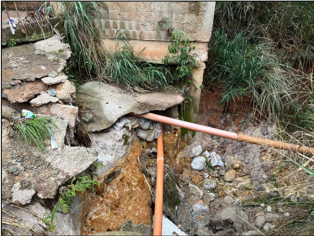
Pilar do prédio localizado na Rua Alameda das Cotovias completamente exposto.
