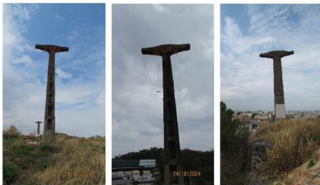
Torres do teleférico na atualidade dentro da Fazenda do Confisco.
