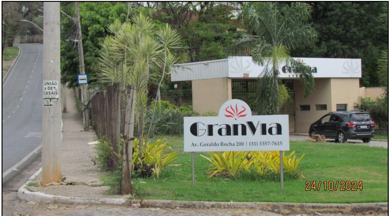
Centro de Eventos GranVia (sede) - Avenida Geraldo Rocha
