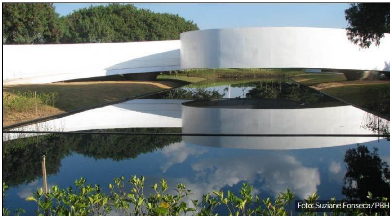
Estação de Tratamento de Água do Parque Ecológico da Pampulha (ETA/PEP).
