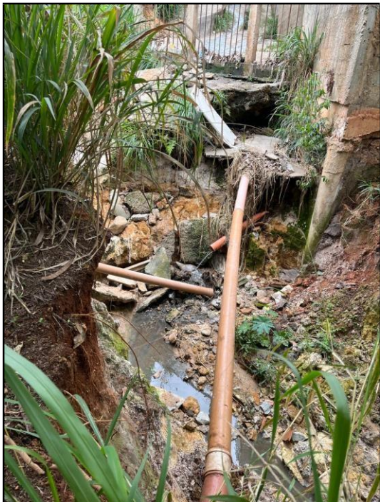
Pilar do prédio localizado na Rua Alameda das Cotovias completamente exposto.
