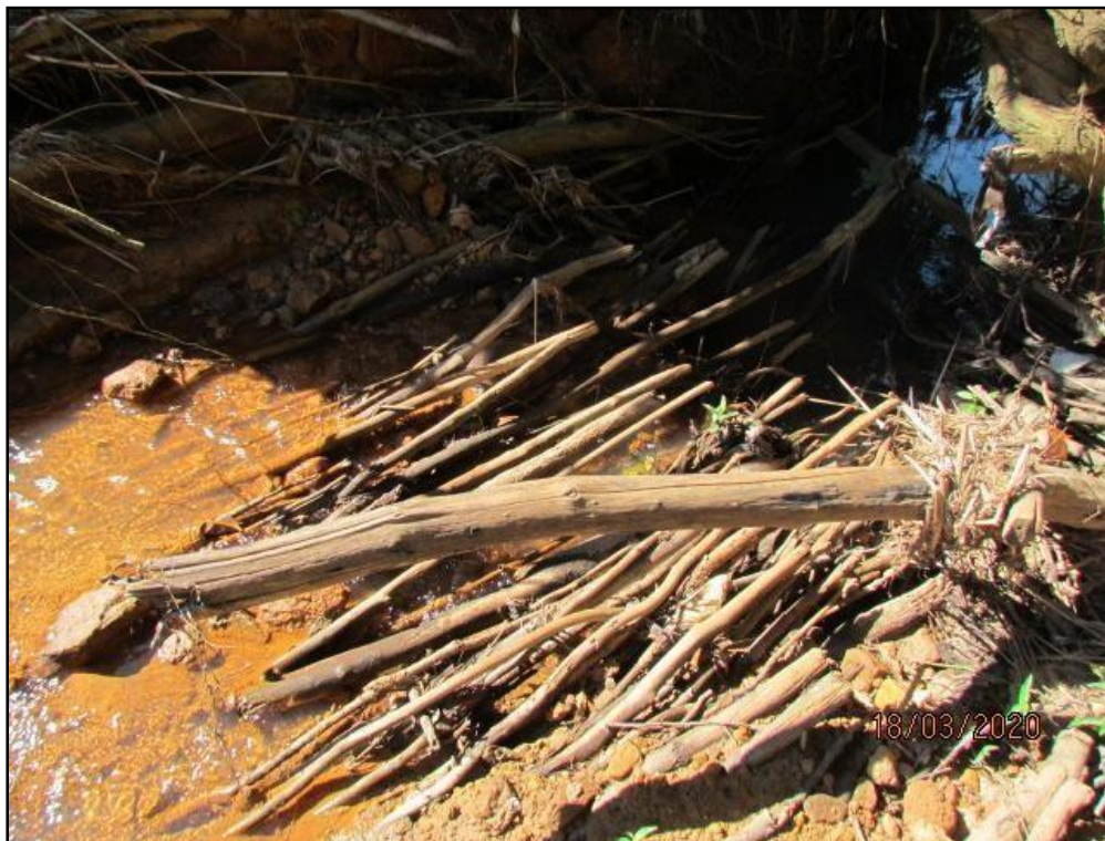
Estaqueamento de madeira usado na construção do barramento à época.
