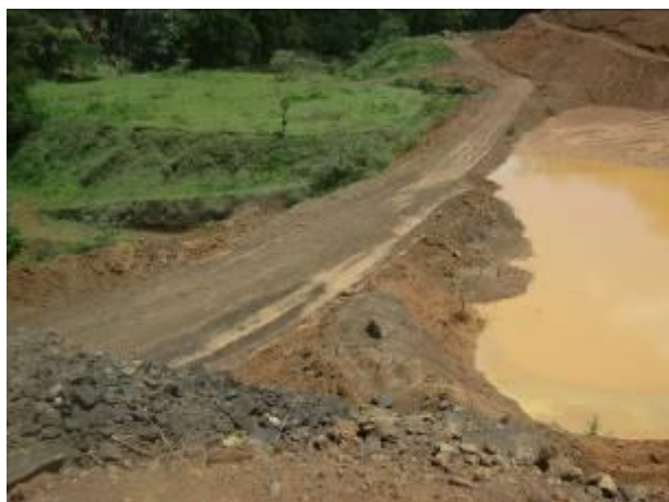
Foto 01: Via interna do empreendimento.
