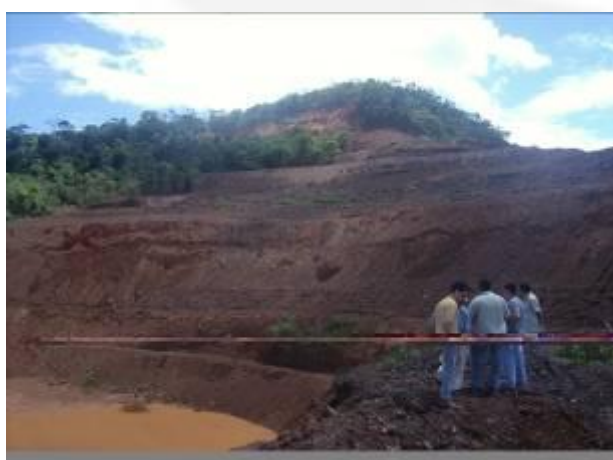
Foto 05: Dique de contenção de sólidos na cota abaixo da frente de lavra.
