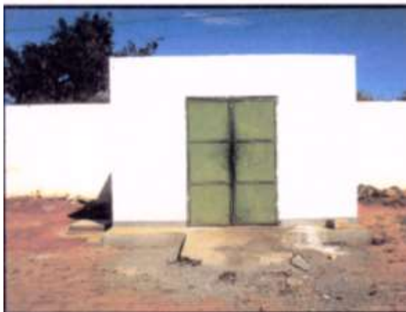
Figura 2. Depósito de resíduos sólidos. Fonte: SEAM, 2015.
