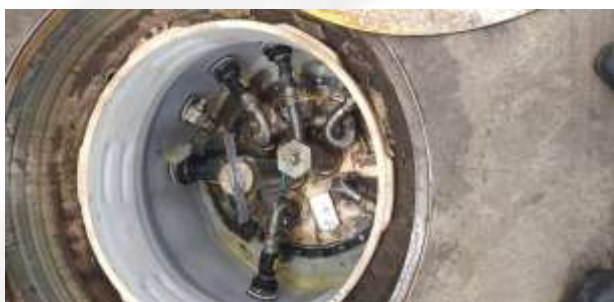
Câmara de acesso à boca de visita
