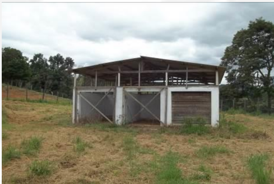
Figura 06: Galpão de compostagem. Fonte: Imagem obtida em vistoria.
