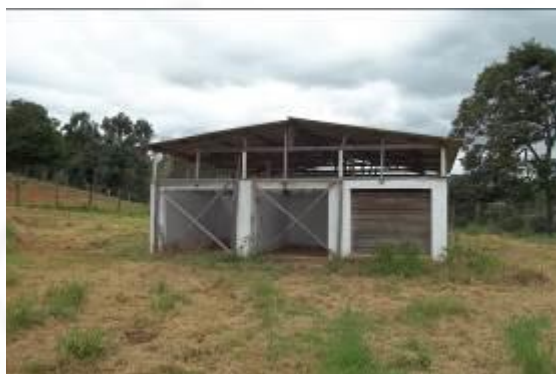
Foto 04. Galpão de compostagem.
