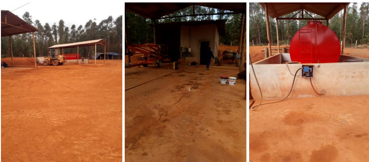
Fotos 14 e 15 – Estrutura de apoio à operacionalização das atividades.
