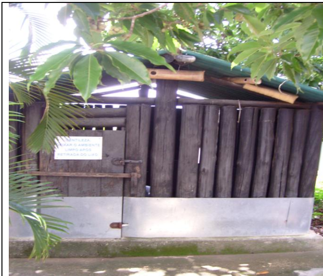
Foto 07: Local de armazenamento dos resíduos sólidos
