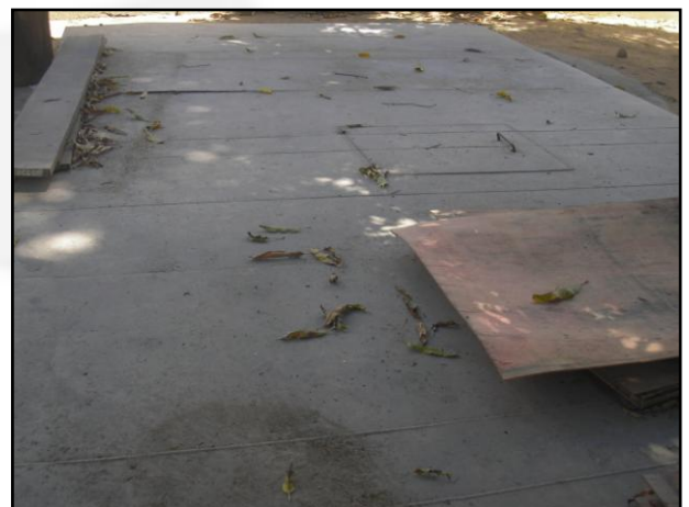
Foto 06: Sistema Fossa-Filtro Anaeróbio.
