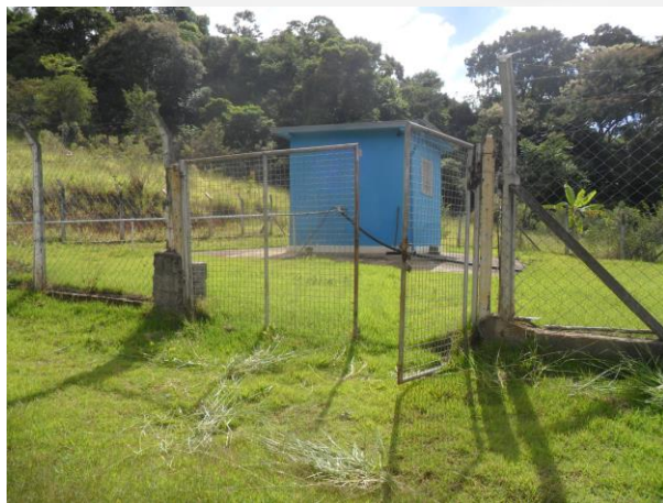
Foto 01. Casa de proteção da fonte
