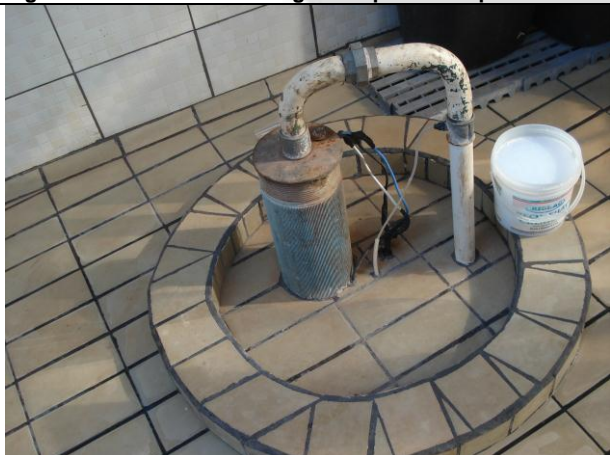
Figura 6- Poço tubular
