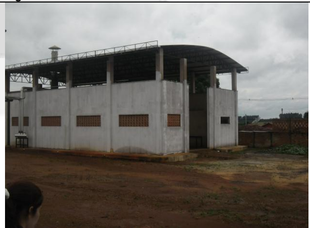
Figura 7- Local onde está localizada a caldeira utilizada na ampliação
