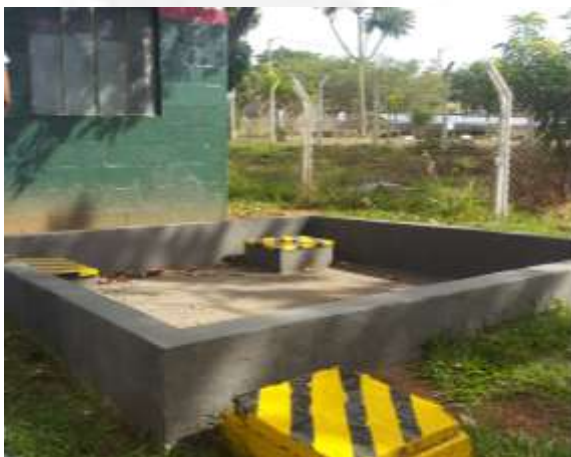
Foto 09. Sistema de Tratamento de efluentes líquidos
