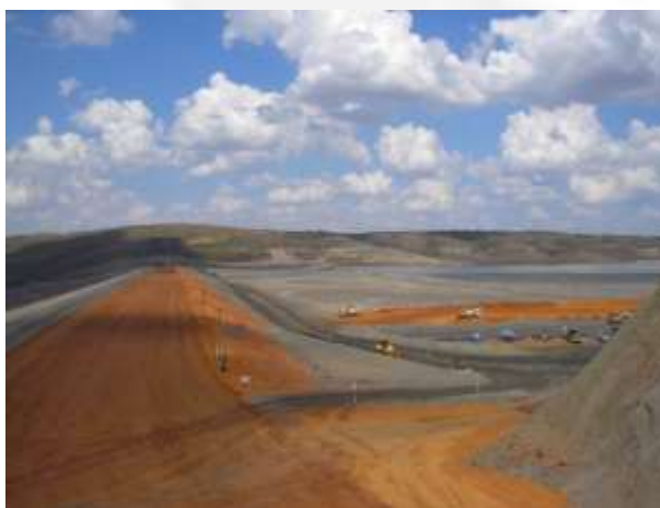
Foto 07. Barragem Eustáquio (alçamento)
