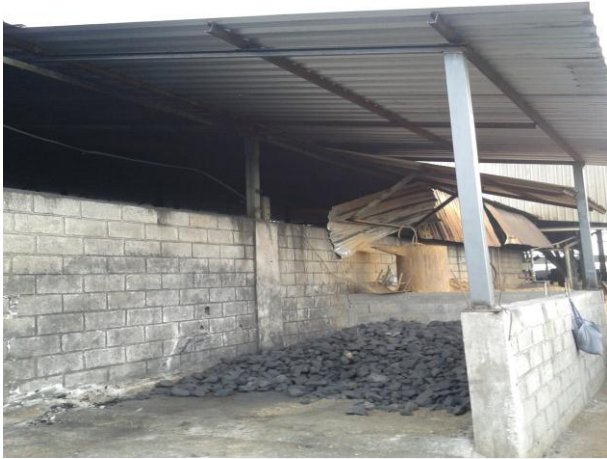
Foto 5. Baía de armazenamento de coque.
