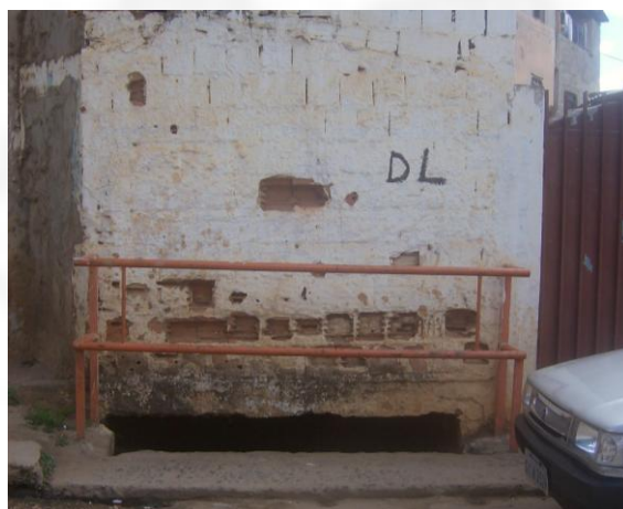
Foto 4: Córrego Santa Cruz, sob residência e travessia.
