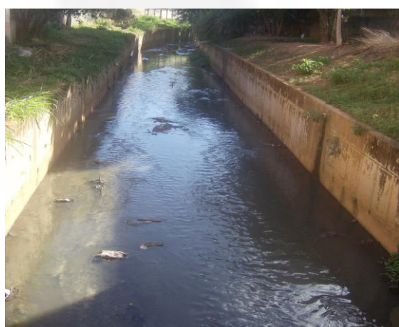
Foto 11: Canalização existente no córrego São João.
