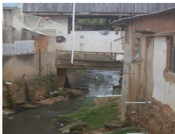
Foto 8: Residência construída sobre o leito do córrego Santa Cruz.
