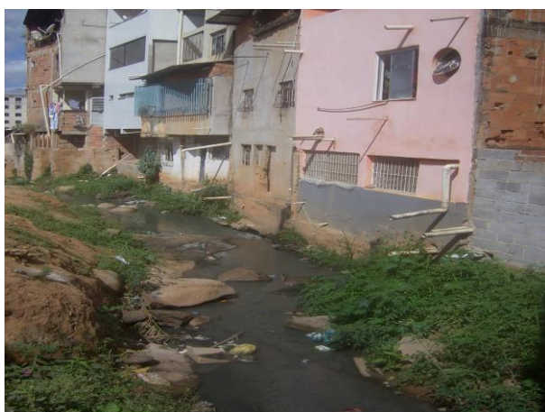
Foto 7: Lançamento de esgotos no córrego Santa Cruz, e ocupação total da APP.
