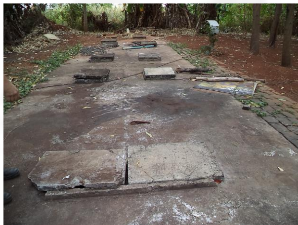
Foto 08. Fossa séptica, filtro e sumidouro
