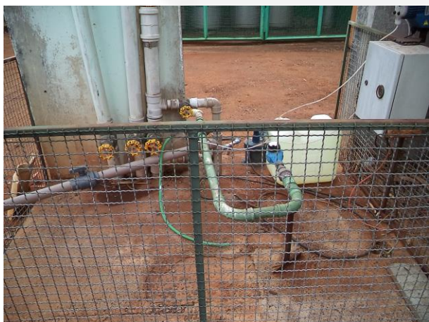
Foto 09. Poço tubular com Hidrômetro e horímetro
