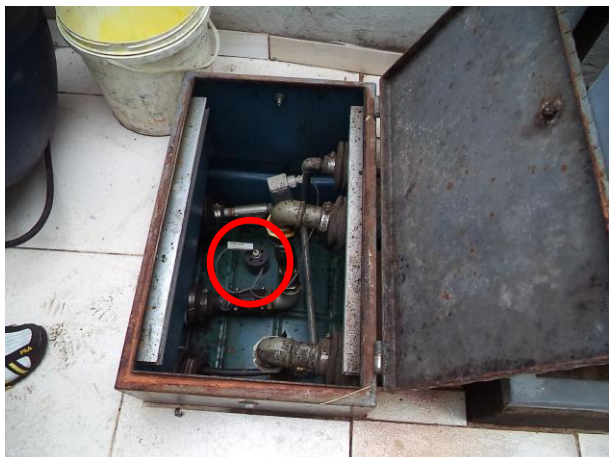
Foto 05. SUMP da unidade de filtragem com sensor de monitoramento
