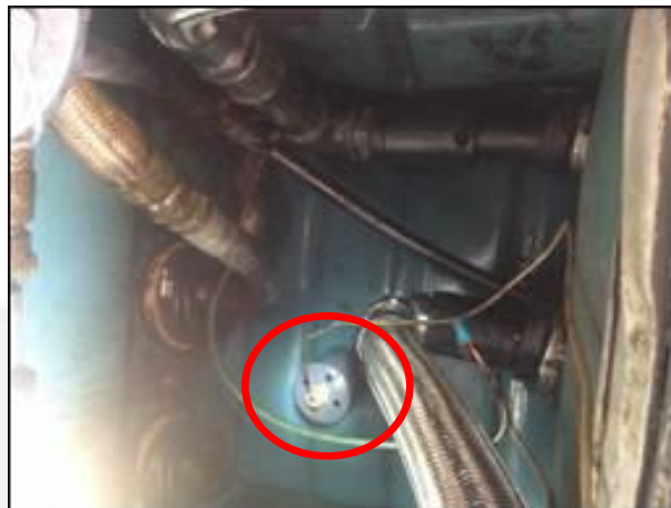
Foto 06. SUMP da Bomba com sensor de monitoramento
