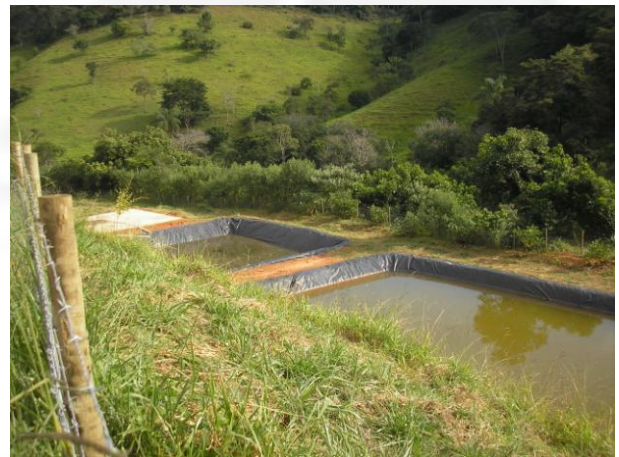
Foto 04. Estação de Tratamento.
