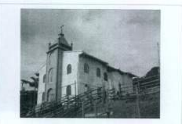
Figura 40 -Igreja de Nossa Senhora Aparecida em construção. Foto Digital – Jan. 2013. Fonte: Luana Carla Martins Campos.
