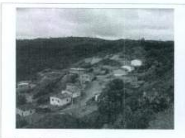
Figura 41 -Vista da área de implantação das Minas do Hogó. Foto Digital – Jan. 2013. Fonte: Luana Carla Martins Campos.
