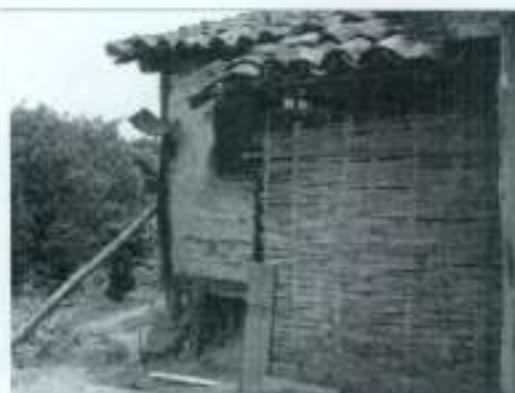
Figura 30 -Edificação de Adão Bento de Souza com parede de esteira de taquara feita pelo morador. Foto Digital – Jan. 2013. Fonte: Luana Carla Martins Campos.
