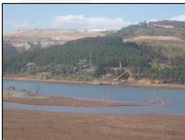
Foto 03. Local de instalação da torre T9 da LT 230kV Taquaril/Itabira 2 – VALE S.A.
