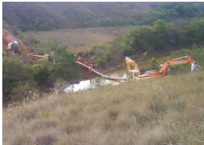
Figura 13 - Exemplo do processo de abertura de vala. Fonte: GASMEG, EIA, 2023.
