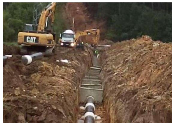
Figura 15 - Lastreamento da tubulação. Fonte: GASMIG, EIA, 2023.
