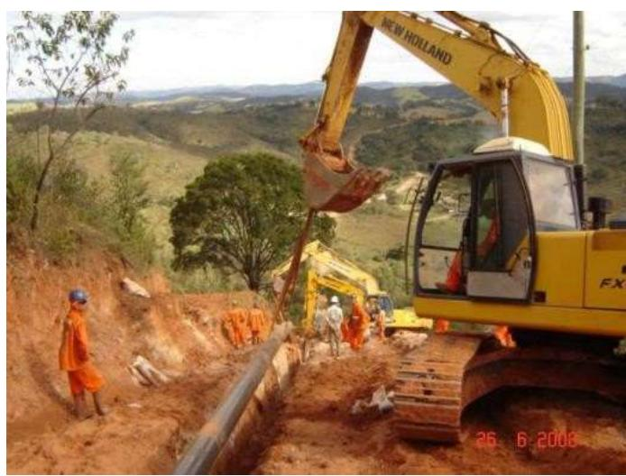
Figura 12- Içamento e abaixamento do duto na vala. Fonte: GASMIG, EIA, 2023.
