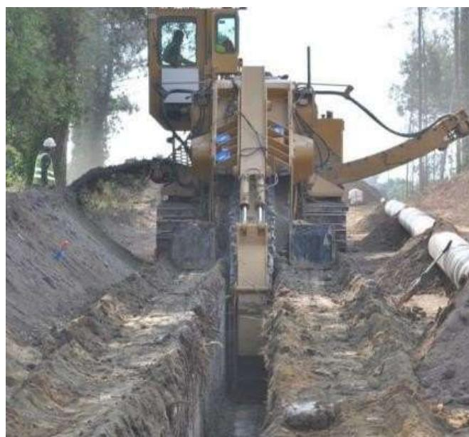
Figura 10 - Ilustração de abertura de vala. Fonte: GASMIG, EIA, 2023.
