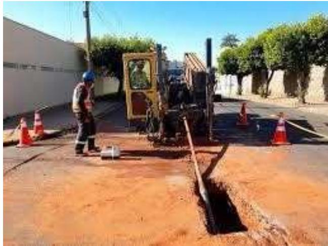
Figura 18 - Exemplo de utilização do Método Não Destruutivo destacando-se a pequena intervenção em superfície para execução do procedimento. Fonte: GASMIG, EIA, 2023).
