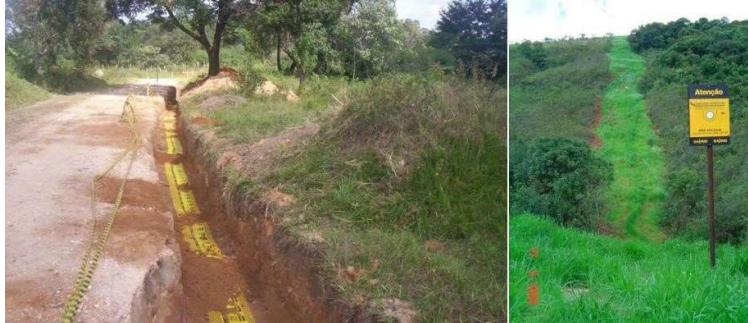
Figura 16 - Sinalização do traçado (Fonte: GASMEG, EIA, 2023).
