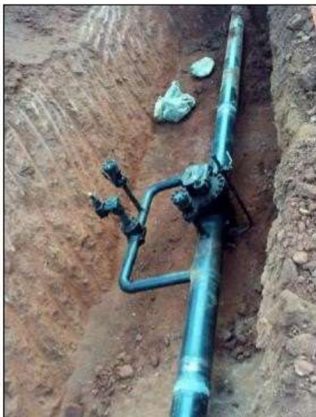
Figura 7 - Modelo de válvula a ser instalada no projeto Fonte: GASMIG, EIA, 2023.
