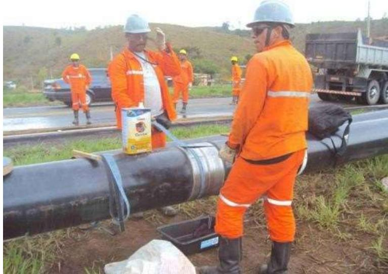
Figura 11 - Revestimento das soldas. Fonte: GASMIG, EIA, 2023.
