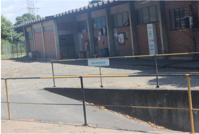
Foto 8: Tanque de decantação da drenagem pluvial
