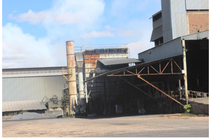
Foto 4: Despoeiramento da descarga de carvão
