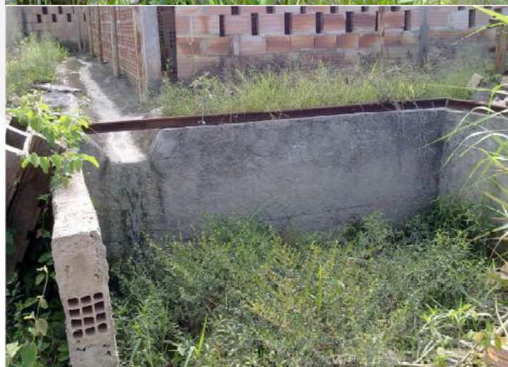
Figura 6. Instalação do sistema de drenagem
