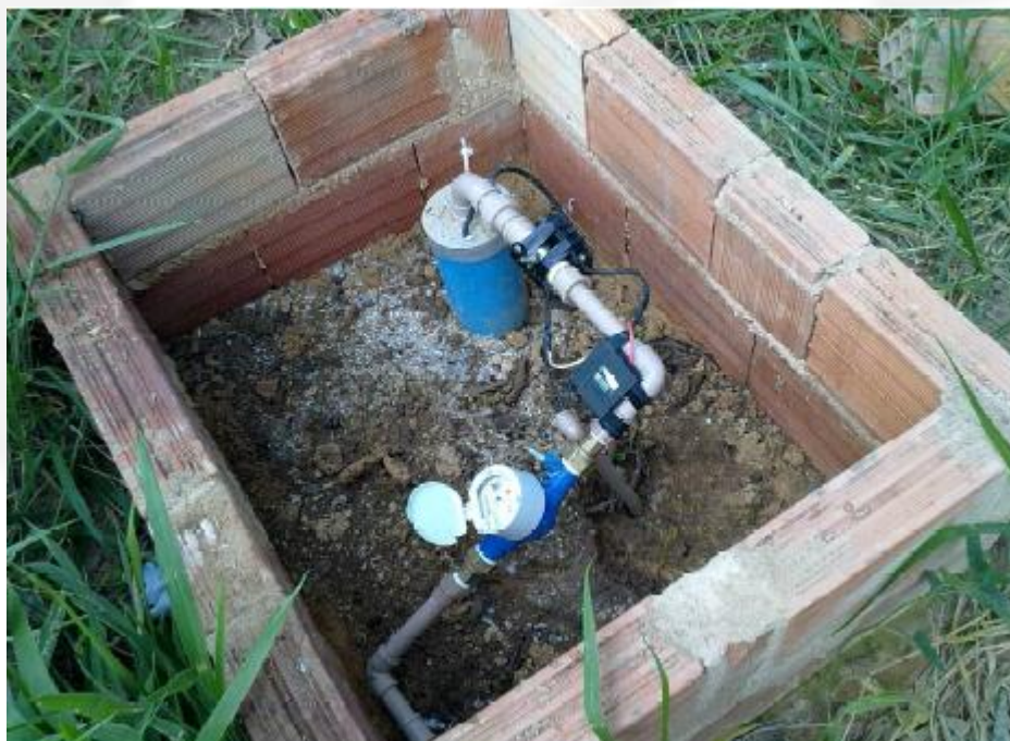
Figura 4. Instalação de horímetro e hidrômetro
