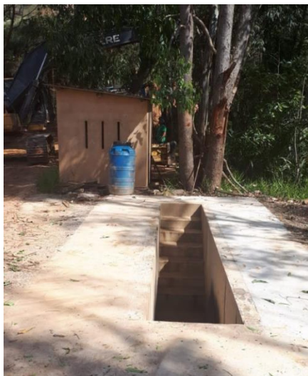
Foto 1. Lavador de veículos com piso impermeabilizado
