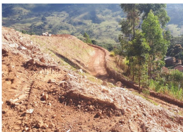
Foto 4. Talude da pilha de estéril J com correção de erosões e início de revegetação
